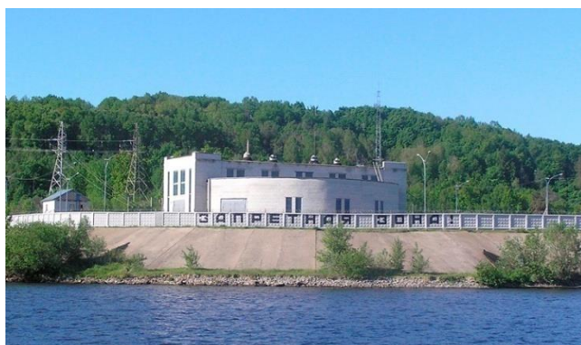
Береговая насосная станция
